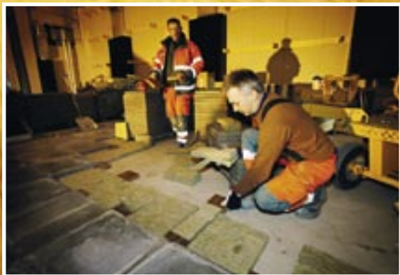
Handvärk. Roger Nordlund lägger ut en av de hundratala gummiplattor som ska hindra ljudet i en av konsertsalarna att fortplanta sig till andra delar av byggnaden.
